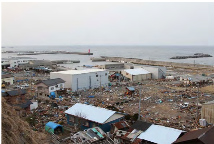
▲ 津波被害を受けた八木地区水産加工工場
