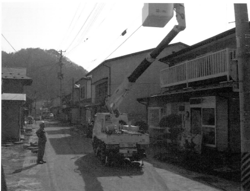
小本地区の電気復旧作業
