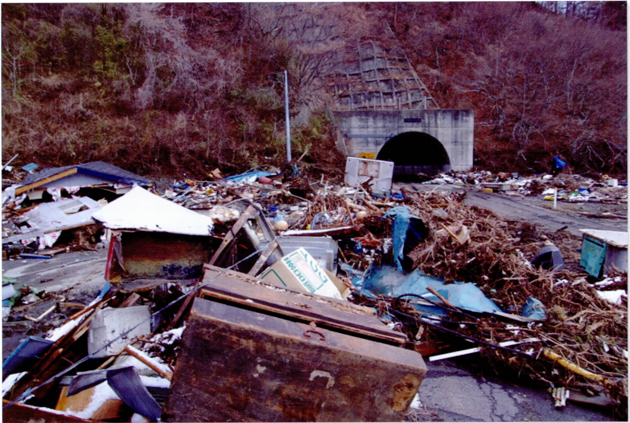
国道 45 号、小成地区
