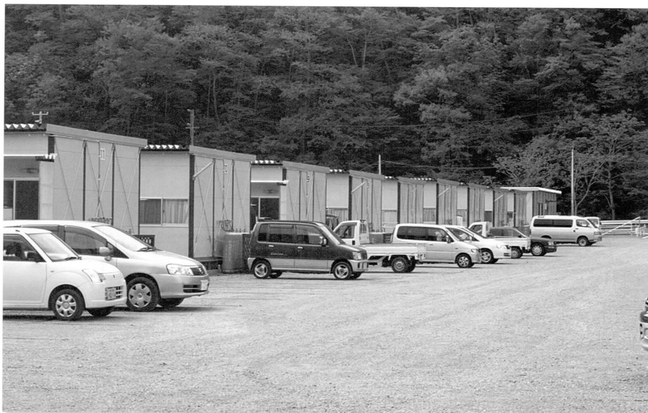
仮設住宅小本団地
