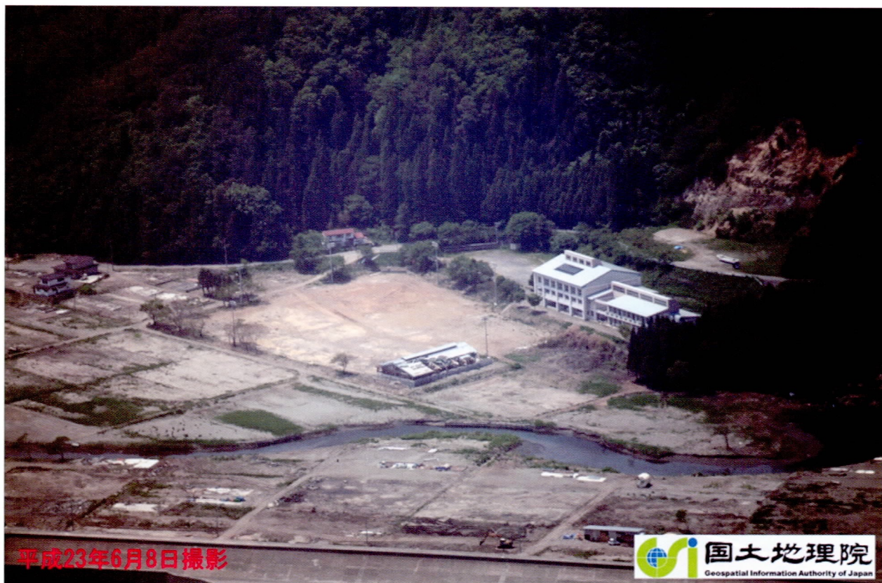
小本中学校の屋内プール（写真中央）の惨状が津波のすさまじさを物語る
