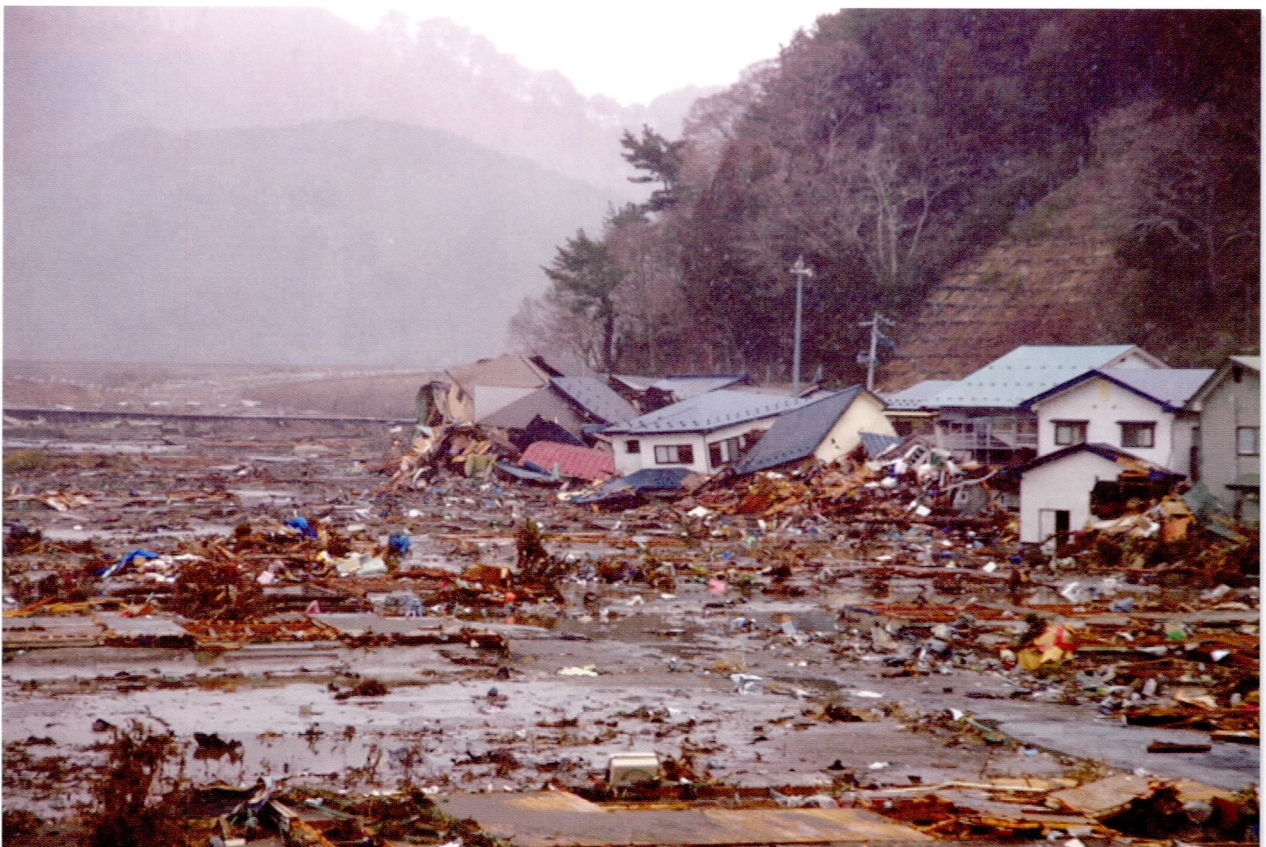
被災した小本地区
