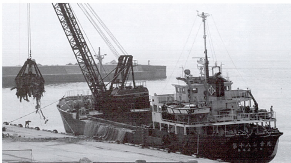
宮古市のがれきを積んだ船が小本港に入港
