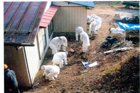
川前町の民家で行った除染作業(12月14日)
