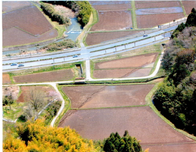
常磐藤原町地内の主要地方道いわき石川線付近。水田に地割れが見て取れる。簡易補修した道路は、色が変わっている (4月18日 県消防防災航空隊提供)
