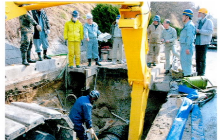
泉町下川地内の国道6号の水道管復旧工事 (3月25日)
