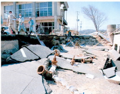
久之浜の蔭磯橋では、津波により損壊した水道管がむき出しに(4月14日)
