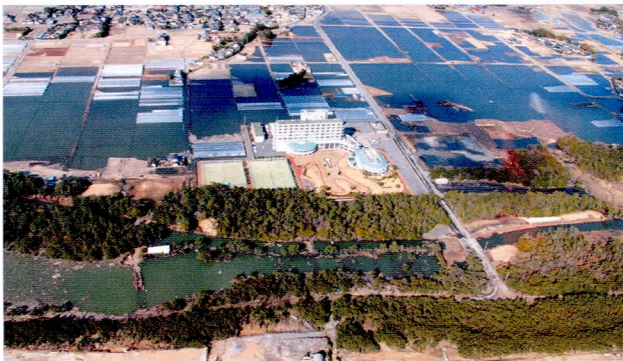
新舞子海岸付近の水田も津波で浸水 (3月12日 県消防防災航空隊提供)
