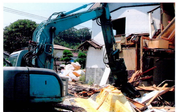
被災した家屋の解体撤去作業(7月15日)
