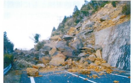
4月11日、常磐道いわき勿来IC～いわき湯本ICで斜面が崩落(東日本高速道路(株)提供)
