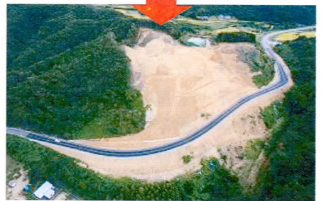
(上)4月11日、いわき石川線の渡辺町上釜戸地内で斜面が崩落
