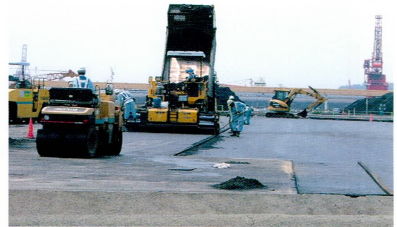
復旧が進む小名浜港5・6号ふ頭(7月25日)
