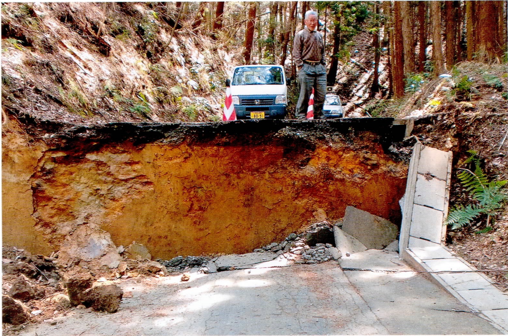
田人町には複数の断層が走っている。4月の余震で2mほどの段差ができた道路が何カ所も発生 (4月13日)
