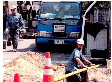
常磐上湯長谷町でのガス管修繕工事 (4月15日：常磐共同ガス(株)提供)
