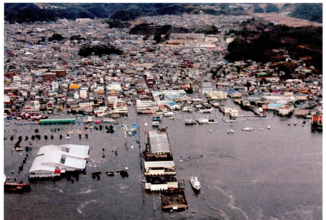
津波で孤立した「いわき・ら・ら・ミュウ」。施設は、11月25日に再オープンした (3月11日15:50ごろ 県消防防災航空隊提供)
