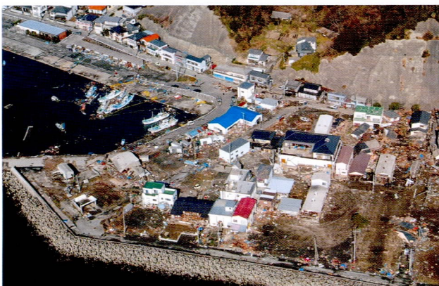
数多くの水産加工場が津波で被災した折戸地区 (3月12日 県消防防災航空隊提供)
