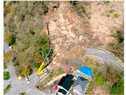
斜面が崩落し道路が完全にふさがれた内郷内町の市道宮沢・蛭内線(4月26日)
