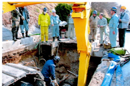
泉町下川境内国道6号的自来水管道路抢修工程(3月25日)
