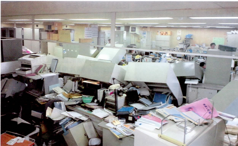
震级6弱的强震造成书架倒塌等，并使磐城市政府大楼遭受巨大损毁。陷入迫不得已将灾害对策本部设置在消防本部的事态
