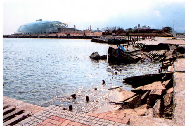
被严重毁坏的水族馆公园码头。远处为海蓝福岛水族馆，已于7月15日恢复营业
