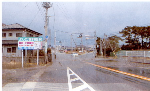
勿来町的关田御城前十字路口付近。由此向南的国道6号公路虽未遭海啸浸水，但是海啸已逼至附近。三岔路右方为旧浜街道 (3月11日16:00左右 磐城国道事务所提供)
