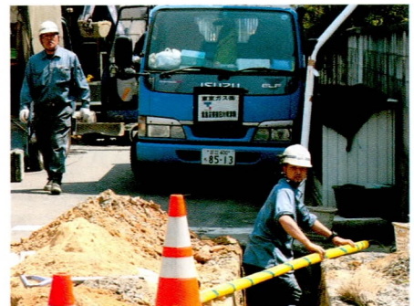
常磐上汤长谷町的煤气管道修复工程现场 (4月15日：常磐共同煤气(株))
