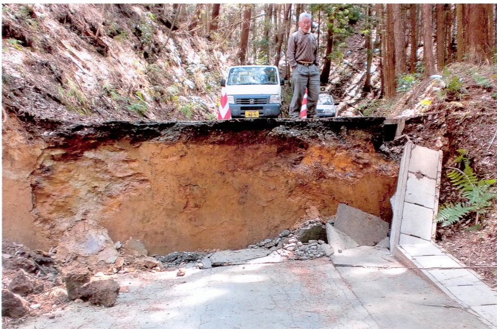
在田人町地下存在多条断层。4月的余震使得多处道路发生2 m左右的高低差异
