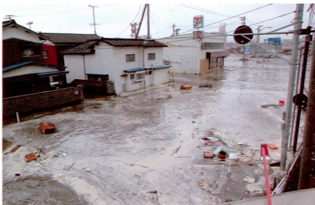
汹涌的海啸将国道6号公路四仓路段沉入大海下 (3月11日15:45左右 磐城日报社提供)
