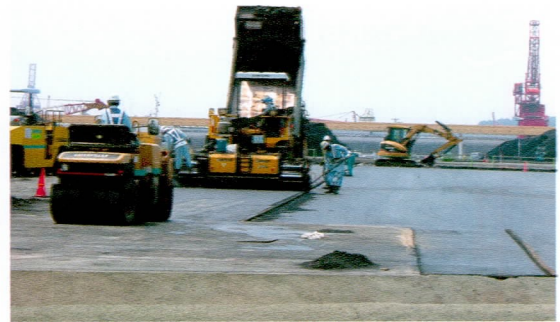
进行修复施工的小名浜港5·6号码头(7月25日)
