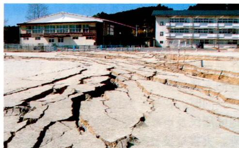
植田小学校园内发生的严重地裂缝（4月6日）
