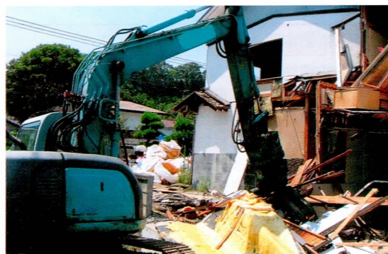
对受灾房屋进行解体拆除作业(7月15日)
