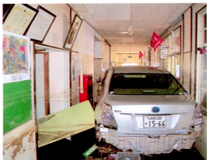
海啸将汽车冲至永崎小学校校舍内 (3月12日)
