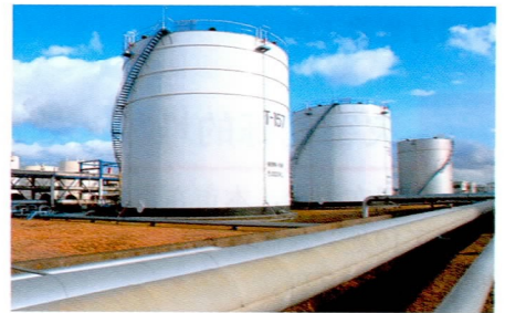
小名滨石油(株)汽油储藏罐
