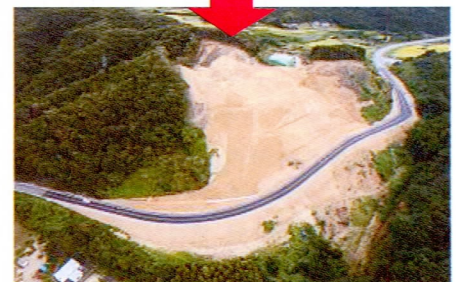
가설 도로에 의해 8월 31일 재개통 (이와키 건설 사무소)
