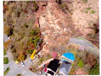
사면이 붕괴되어 도로가 완전히 막힌 우치고우치지역의 미야자와 히루우치내선 (4월26일)
