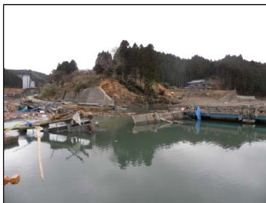
国道45号宮城県南三陸町水尻橋
