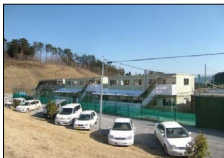
↑仮設ハウス(南三陸町仮庁舎)
