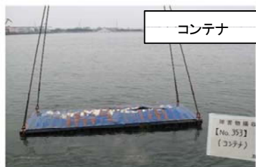
障害物の引き揚げ作業
