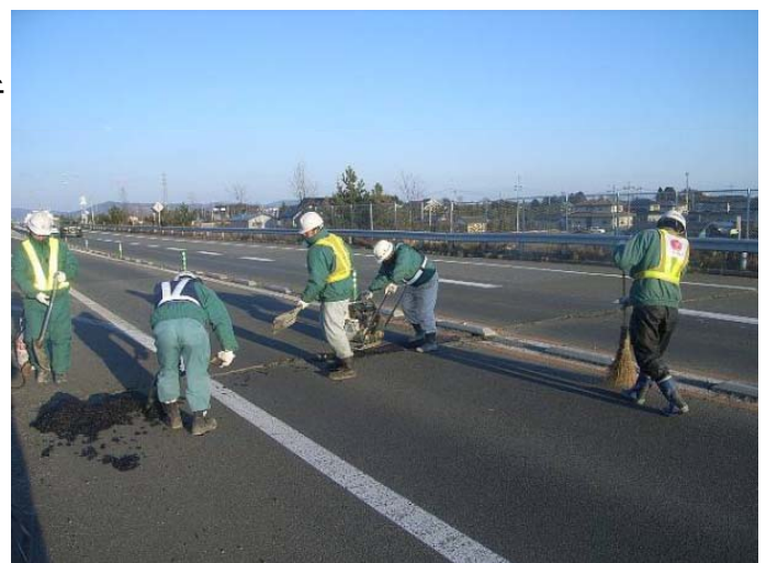
▲常温合材による応急復旧
