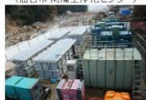
膜処理ユニットによる処理場と別位置での応急対応状況(陸前高田市)
