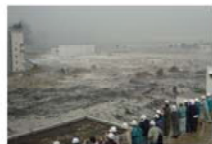
津波により浸水する下水処理場(仙台市南藻生浄化センター)
