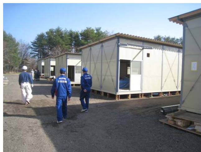
やまだまち 仮設住宅調査状況(岩手県山田町)
