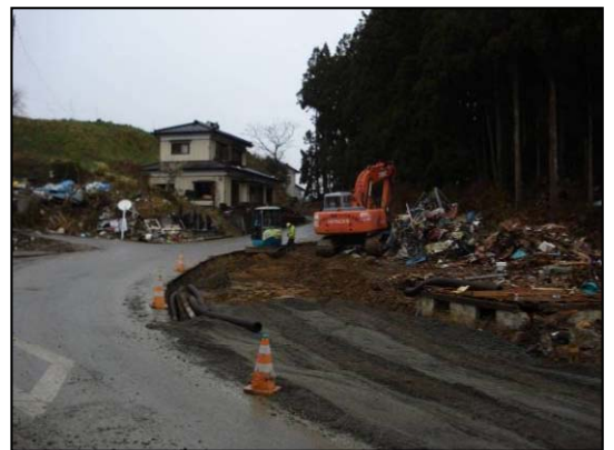
隘路箇所の拡幅工事状況
