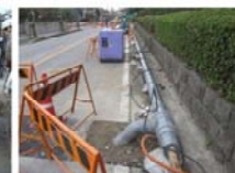
仮設配管による応急復旧状況(千葉県習志野市)
