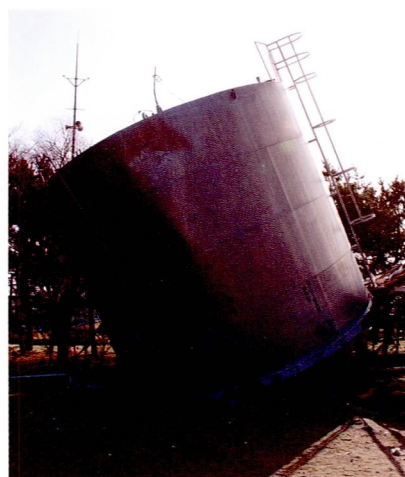
流され破損した 220kl入り重 油タンク
