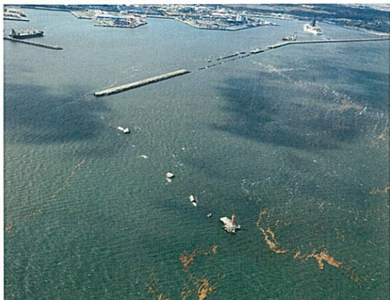
被災状況（平成 23 年 3 月 12 日時点）
