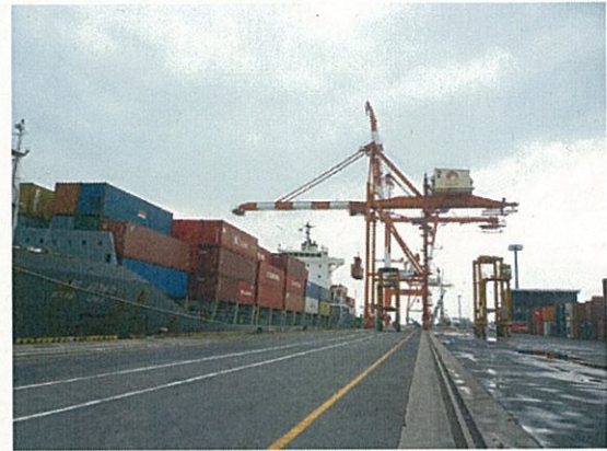
荷役状況（平成23年9月30日時点）
