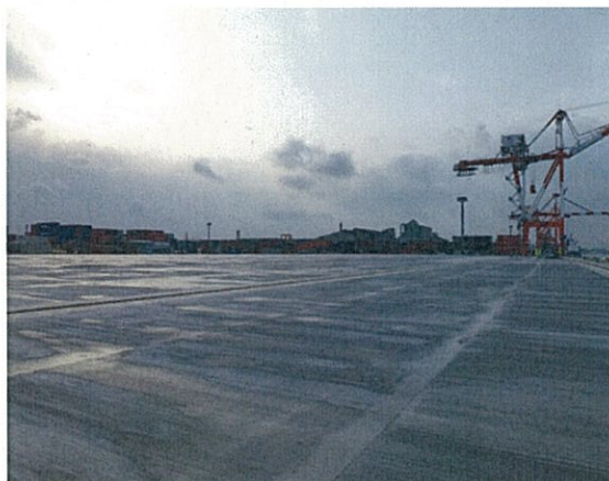
復旧状況（平成 23 年 12 月 16 日時点）
