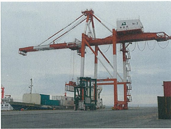
荷役状況（平成23年4月23日時点）
