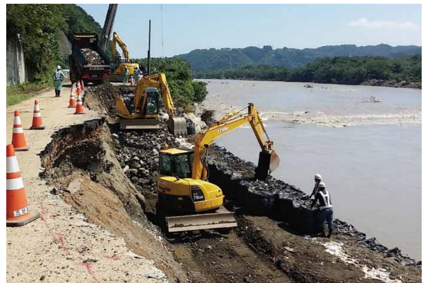
応急復旧工事中(9月1日)
