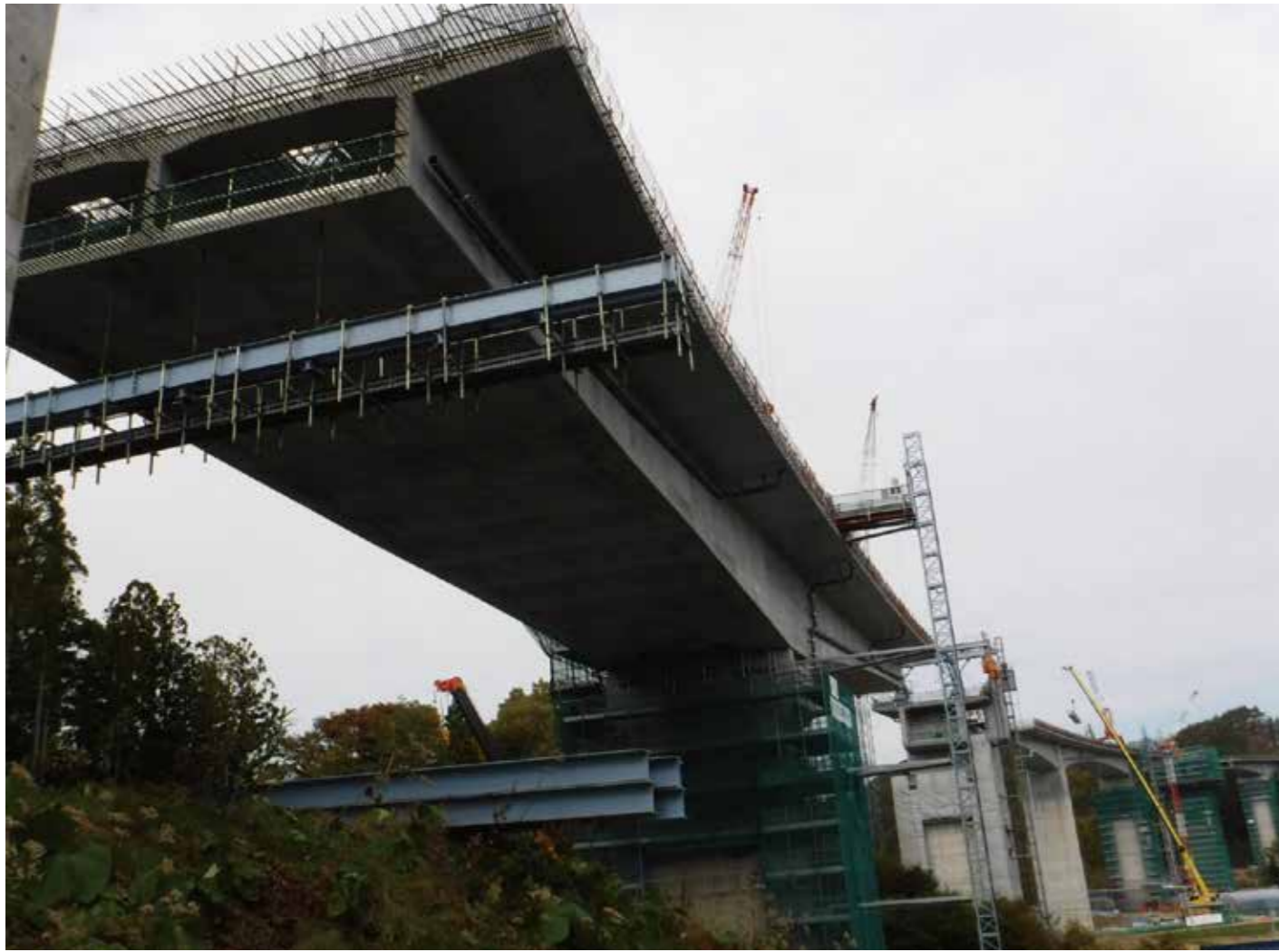
夏井高架橋(仮称)の施工状況 三陸沿岸道路 久慈北道路
