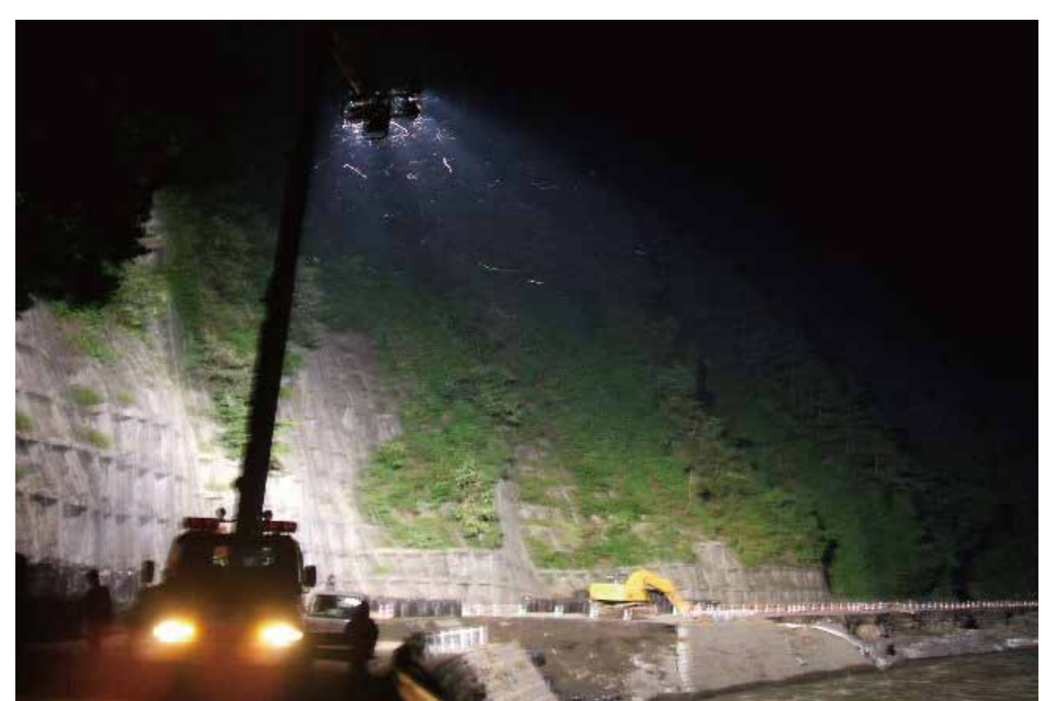
照明車を出動させ昼夜間作業実施
