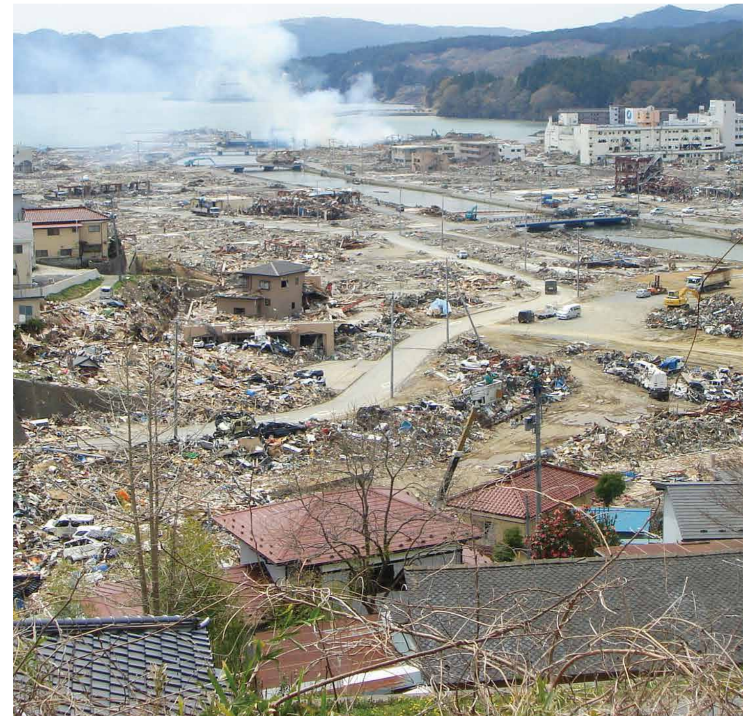
南三陸町(志津川地区)の被災状況
