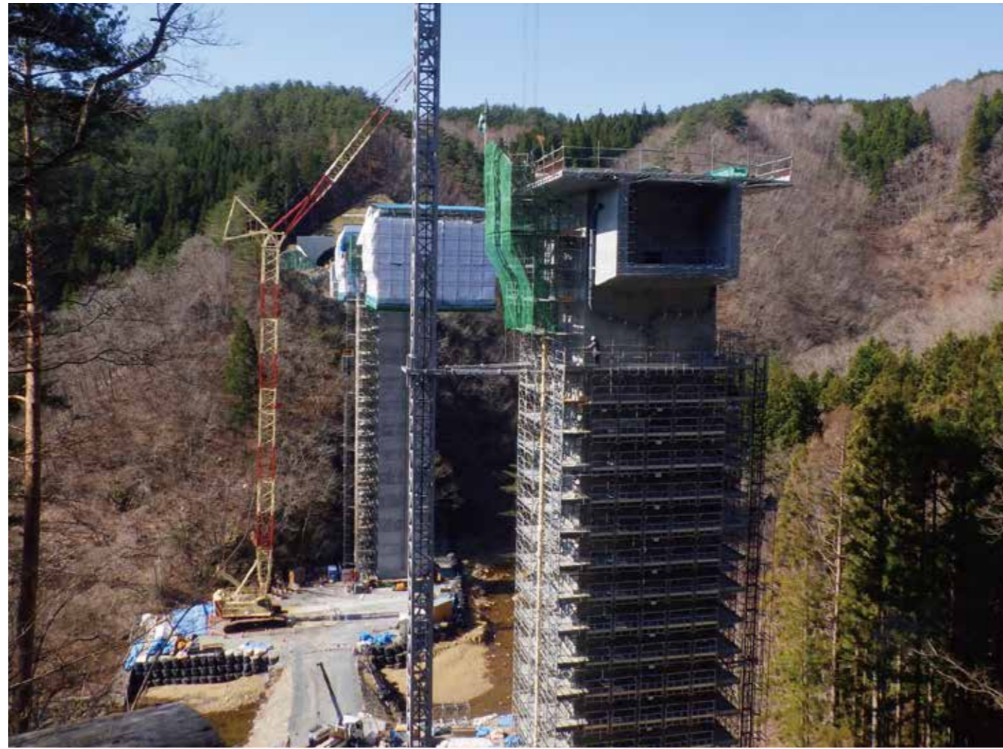
長内川橋(仮称)の施工状況 三陸沿岸道路 宮古田老道路
