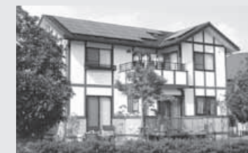
太陽光発電システム
