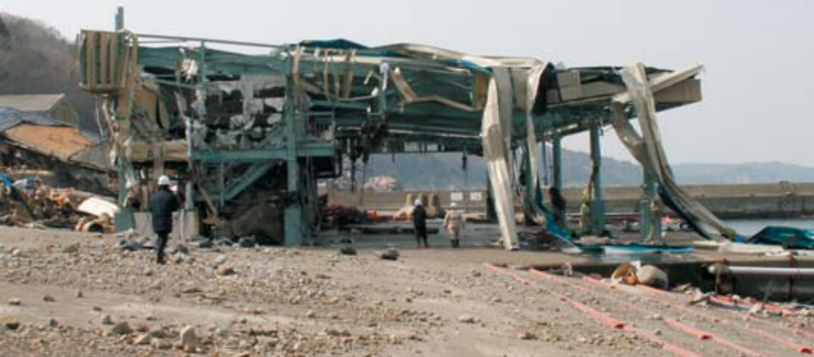
すさまじい津波の破壊力。堀内市場も壊滅状態（14日午後1時50分）
