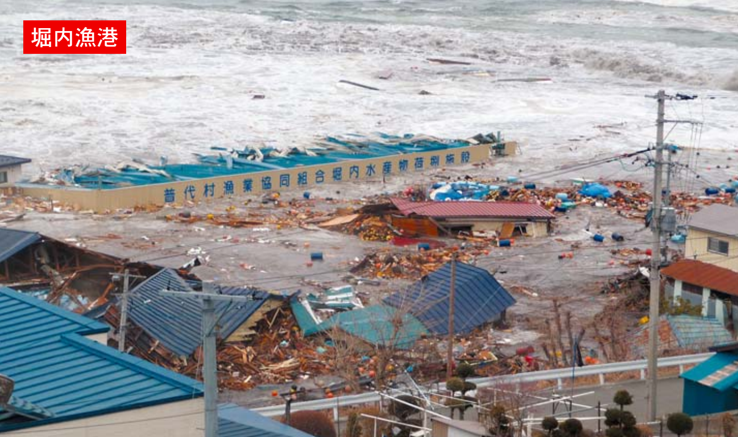
巨大津波は堀内漁港の荷さばき施設の屋根まで到達（11日午後3時31分、国道45号から撮影）
