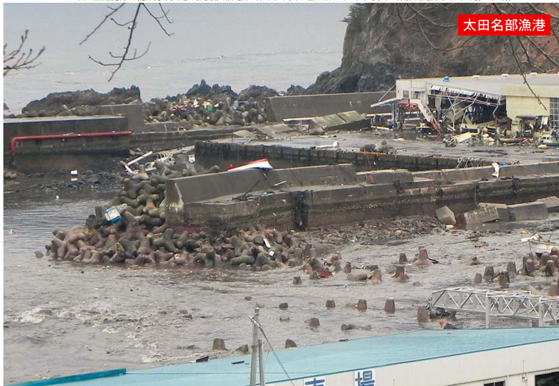
太田名部漁港内の海底が見えるほどの引き波。飛び散ったテトラポット、崩れたケーソン。すさまじい津波の破壊力だ（11日午後3時53分）
