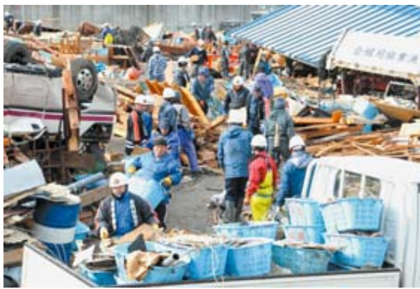
17日、皆が力を合わせ本格的な撤去作業が始まった
