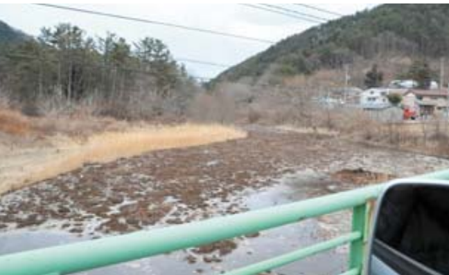
津波到達後の普代橋から見た普代川。逆流はしていないが水かさが増している（11日午後3時50分）
