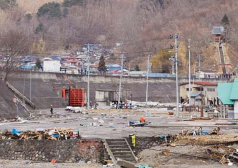
太田名部防潮堤の海側は壊滅的でしたが、無傷だった写真奥の住家（13日午前8時24分）
