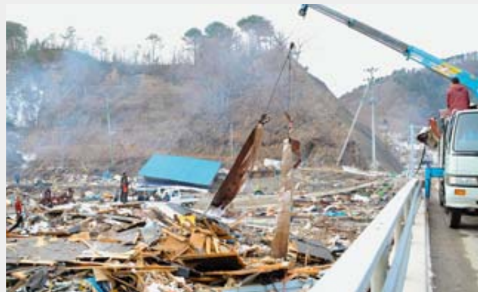
作業場などが全壊した大沢地区のがれき撤去をする漁業者（17日午後3時42分）
