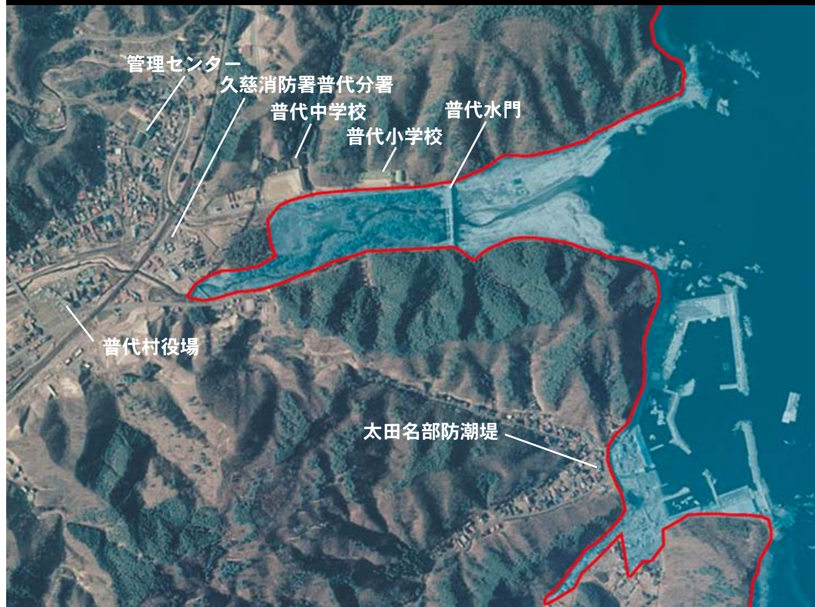
平成23年3月11日の津波の浸水区域を普代分署員に表してもらいました。津波は15.5mの普代水門を超え、普代川をさかのぼり、村漁協裏まで到達しました。遡上高(津波が達した高さ)約22mと推測されます。一方、太田名部地区では、津波は15.5mの防潮堤の半分ぐらいまで達しましたが、防潮堤の中の住家に被害はありませんでした。しかし、漁船や加工場、荷さばき施設などは壊滅したほか、防潮堤がない大沢地区は津波の直撃を受け作業場は全滅しました
