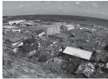
八木南港周辺では多くの建物が損壊（12日、10時37分）
