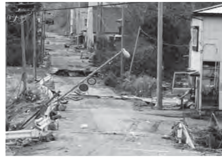
住宅などの建物が損壊し、道路の舗装も流出（12日、9時50分）
