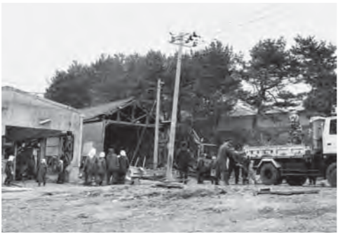
宿戸漁港ではがれきを撤出（3月22日）
