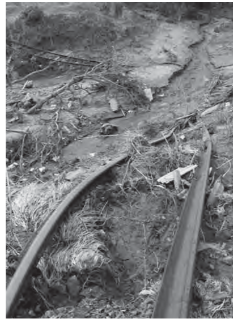
川へ落ち、分断したJR八戸線の線路 (13日、11時30分)
