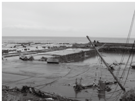
港内のほとんどの物が流出した (16時42分)
