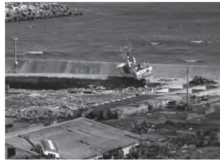
八木南港の防波堤に打ち上げられた漁船（12日、10時13分）
