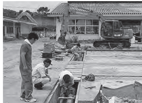
復旧の作業状況を確認する箱石所長(左)
