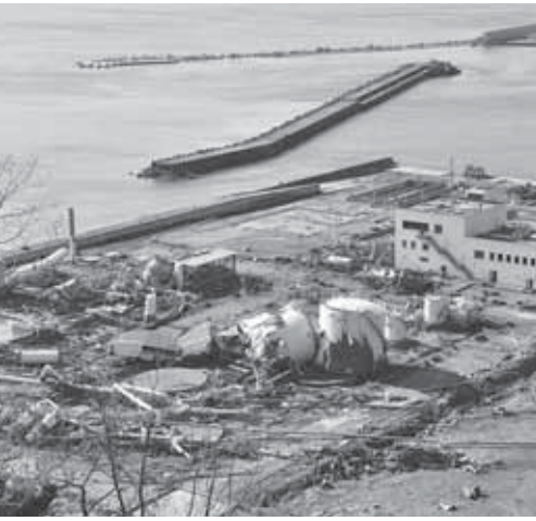
地上施設がほぼ全壊した国家石油備蓄基地。辺り一面が信じられない光景に
