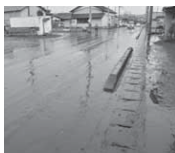
浸水し、泥にまみれた国道395号
