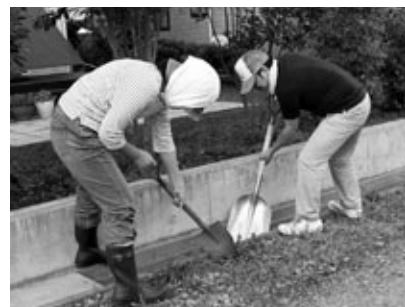
側溝から上げた堆積物は土のう袋に
