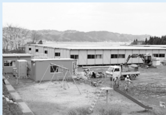
赤前小学校グラウンド内の仮設住宅
