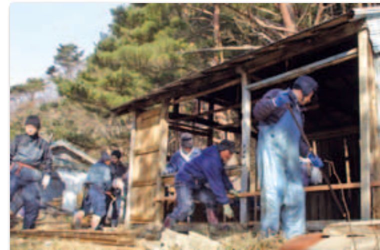
約30人のボランティアが力を合わせて机浜番屋群を修繕
