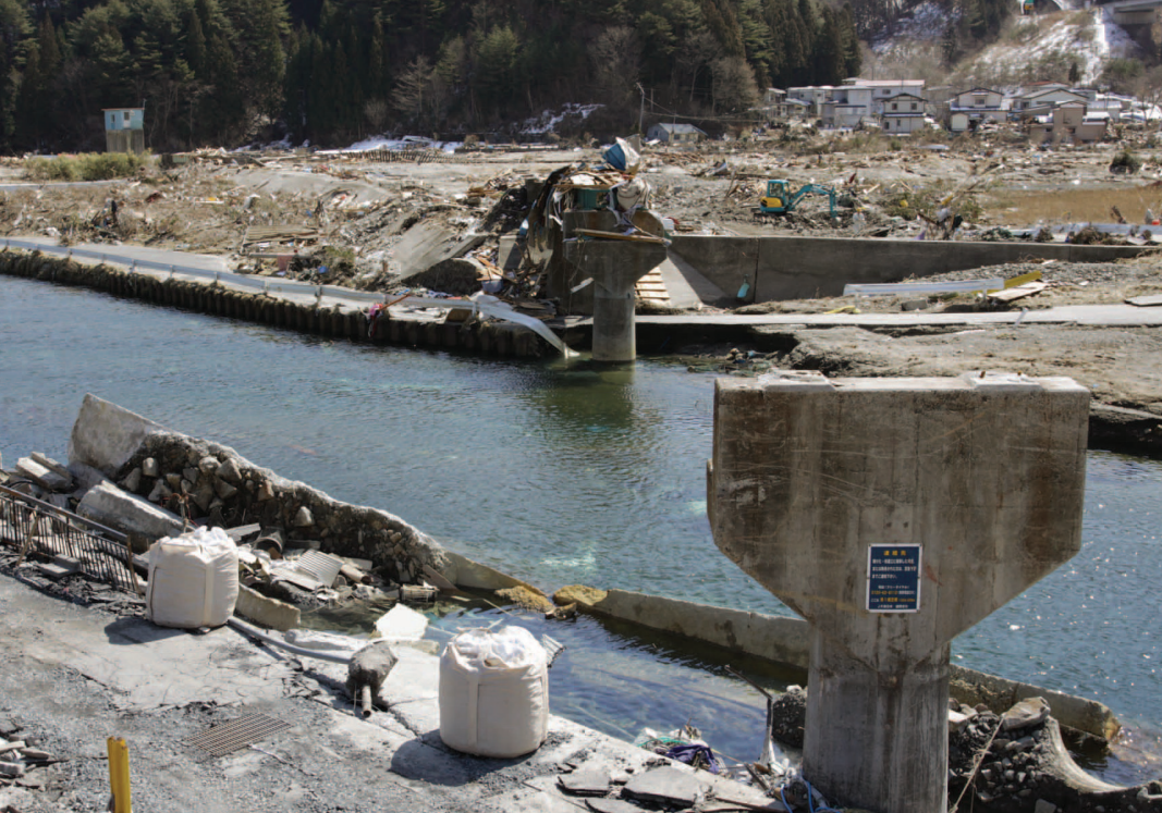
津波により破壊された織笠川に架かる J R 山田線の鉄橋
