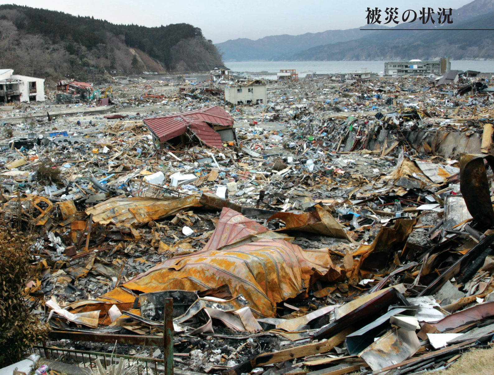
地区の大半が浸水し火災も発生した田の浜地区（3月24日撮影）
