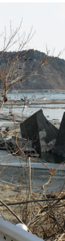
津波の威力によりなぎ倒された田の浜地区の高さ8.35mの防潮堤
