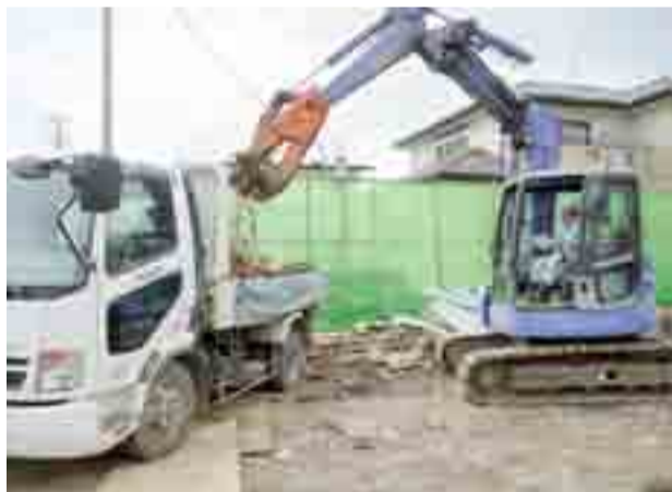
▲家屋解体も進んでいます
