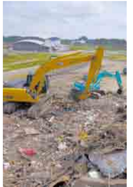
▲重機が一日中動く野蒜の一次仮置き場
