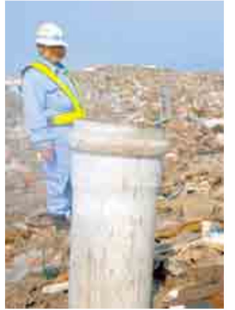
▲煙突を取り付け独自の火災予防(大曲浜の一次仮置き場)
