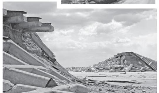
▲津波で破壊された堤防
