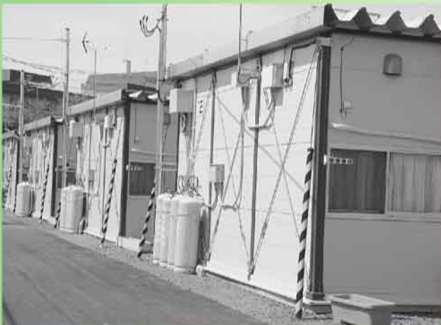
▲今回入居が始まった箱塚桜応急仮設住宅
