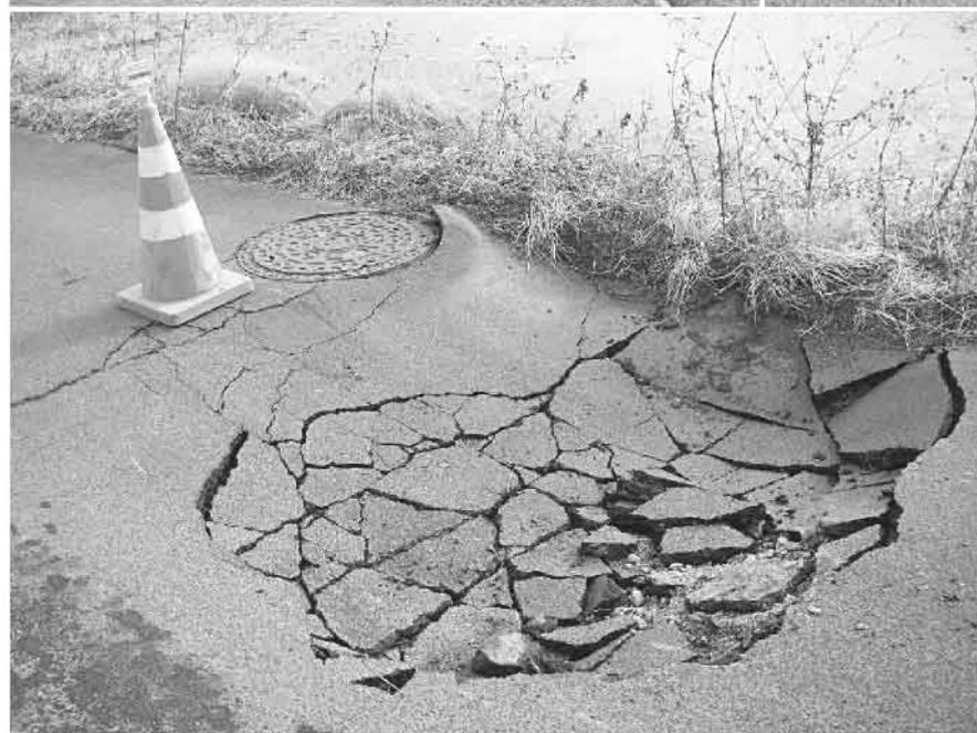
被害のあったマンホールには砕石ですりつけを行うなど、通行に支障のないよう施工していますが、余震などが続いていますので、通過の際は速度を落とすなど十分に注意願います。
