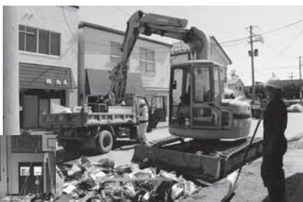
▲ガレキの撤去作業
