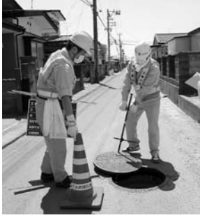
▲マンホール調査：4月25日 桜木地区
