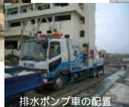
排水ポンプ車の配置
