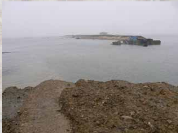
北上川右岸河口・堤防が約1kmに渡り決壊 【撮影：近畿地整】
