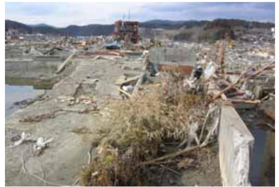
流失した町役場周辺
