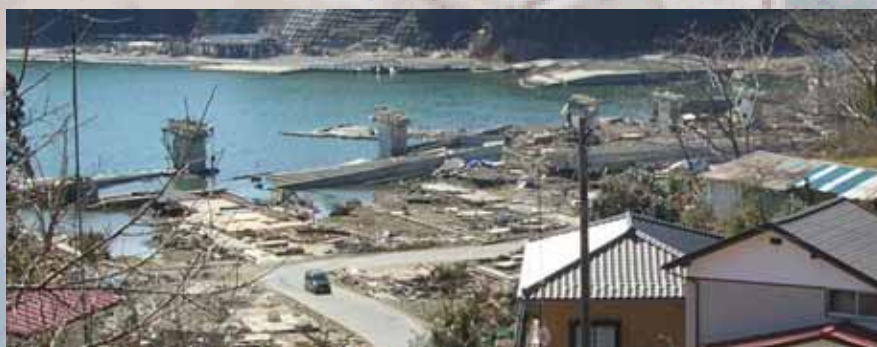
国道45号歌津大橋上部工流出 （宮城県南三陸町）【出典：東北地整】
