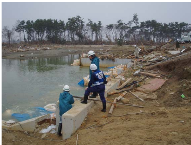
4 / 11 排水実施に向けて仙台市職員と現地調査を実施
