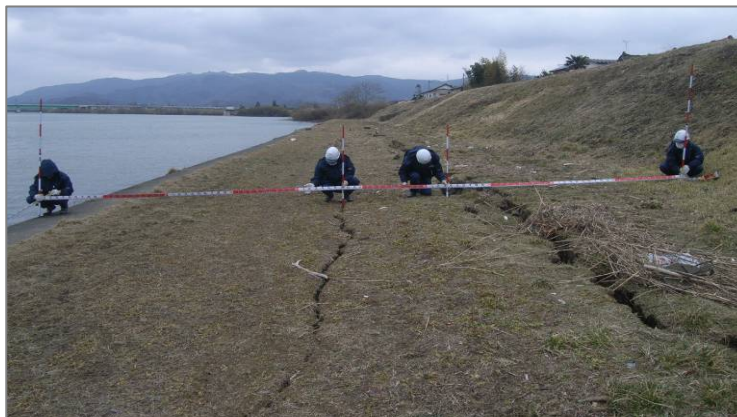
3/16 旧北上川 被災状況調査
