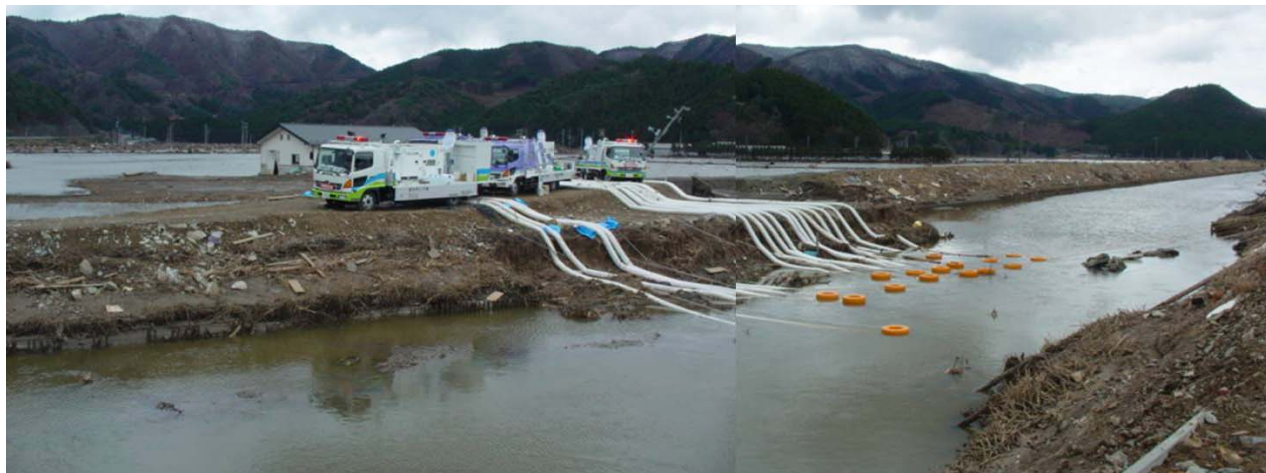
4/20 宮城県石巻市釜谷での排水作業
