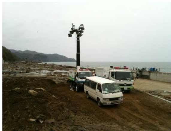
北上川河口部(宮城県石巻市)における排水ポンプ車及び照明車
