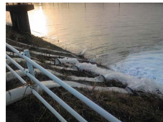
女川排水機場(宮城県石巻市)における排水状況
