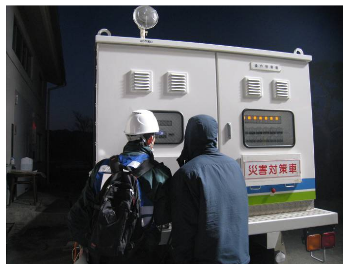
排水ポンプ車運転の注意事項を現場スタッフに指導
