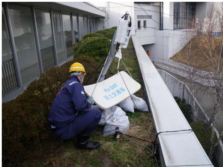
岩手県大槌町において、通信機能を確保するためKu-SAT (衛星小型画像電送装置)を設置し運用を支援
