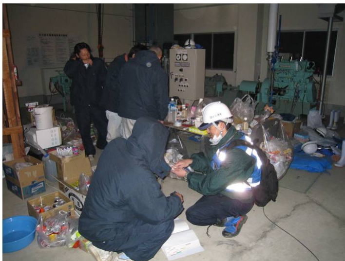
現場スタッフと現地で機器調整
