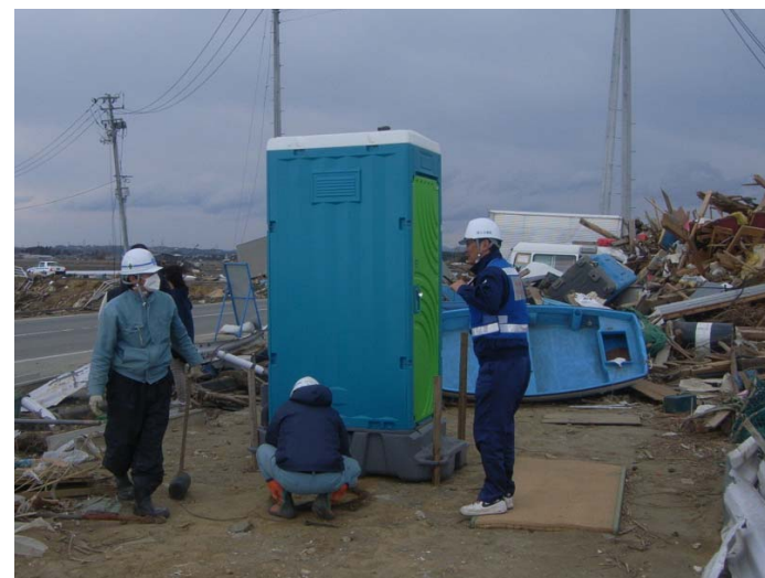
4 / 16 仮設トイレの設営状況を現地で確認
