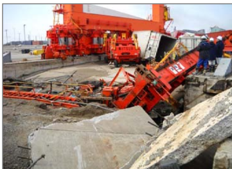
仙台塩釜港 被災状況調査
