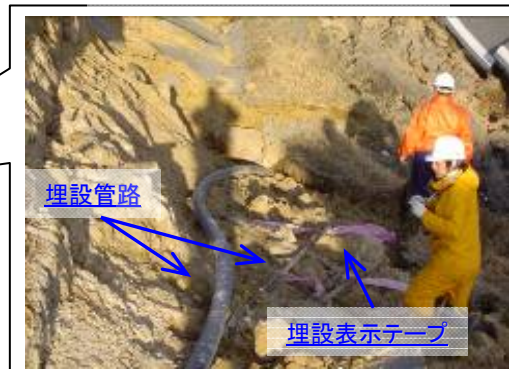
光ケーブル埋設管路 崩壊状況
